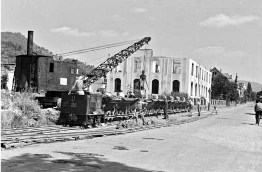
Räumarbeiten in der 1947 noch von den Bombenangriffen gezeichneten Kaiserstraße. Die Arbeiten wurden durch Bagger und sog. Trümmerloren unterstützt.
