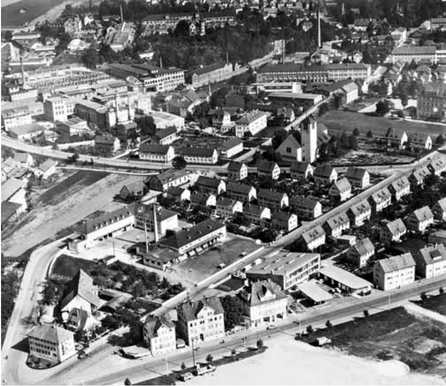
Abb. 17: Blick auf die Christuskirche von Südwesten, Luftbild kurz nach 1956. Es zeigt die in den 1930er Jahren in drei Schritten vollzogene Siedlungsbebauung, ergänzt um die Nachkriegswohnhäuser an der Ecke zur Benzstraße. Die bogenförmig verlaufende Lohmühlestraße hatte damals noch Hauptverkehrscharakter.
