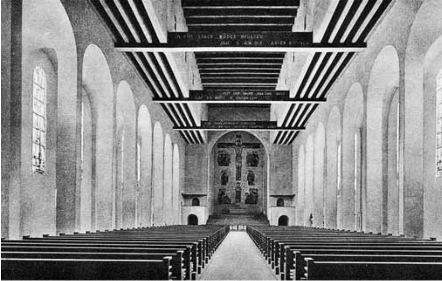
Abb. 14: Die Frauenfriedenskirche (1927–1929) von Hans Herkommer in Frankfurt-Bockenheim. Blick in den Innenraum, Postkarte um 1930. Die Deckenkonstruktion bedurfte noch der Querbinder.
