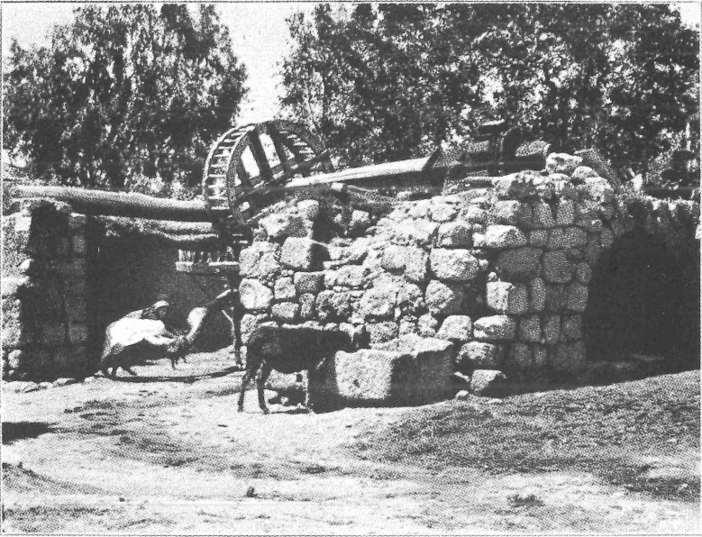
47. Schöpfwerk ( sākie ) mit hochliegendem Heberad (bei kalkilie , ausnahmsweise von einer Frau bewegt). Vgl. S. 225 ff. Aufn. v. Ludwig Preiß, München 1925.
