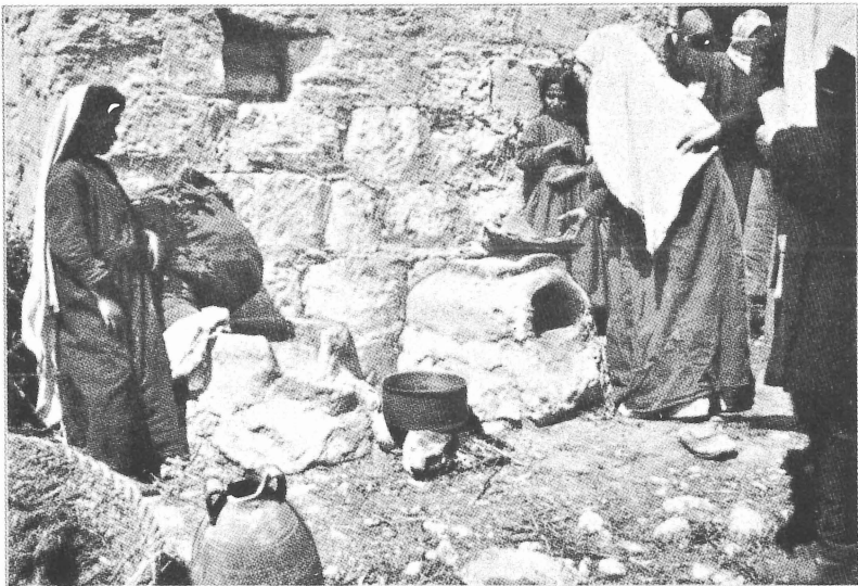
26a. 'arsa (furn) in Beersaba, S. 139, Heizraum mit seitlicher Öffnung, Backraum mit Öffnung nach vorn, l. daneben Kochherde mit Kessel. (Aufn. v. G. Reymann.)
